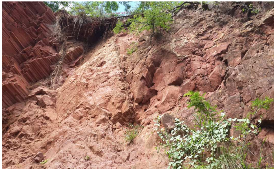
Anexo 4. Transición de areniscas columnares y areniscas masivas sin columnizaciones cortadas por un dique.
