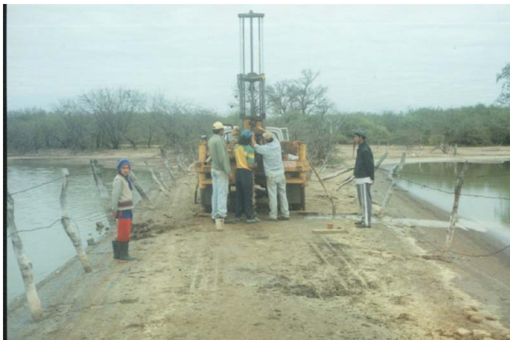
Foto 3. Laguna Isla Po'i, perforación entre las lagunas saladas.
