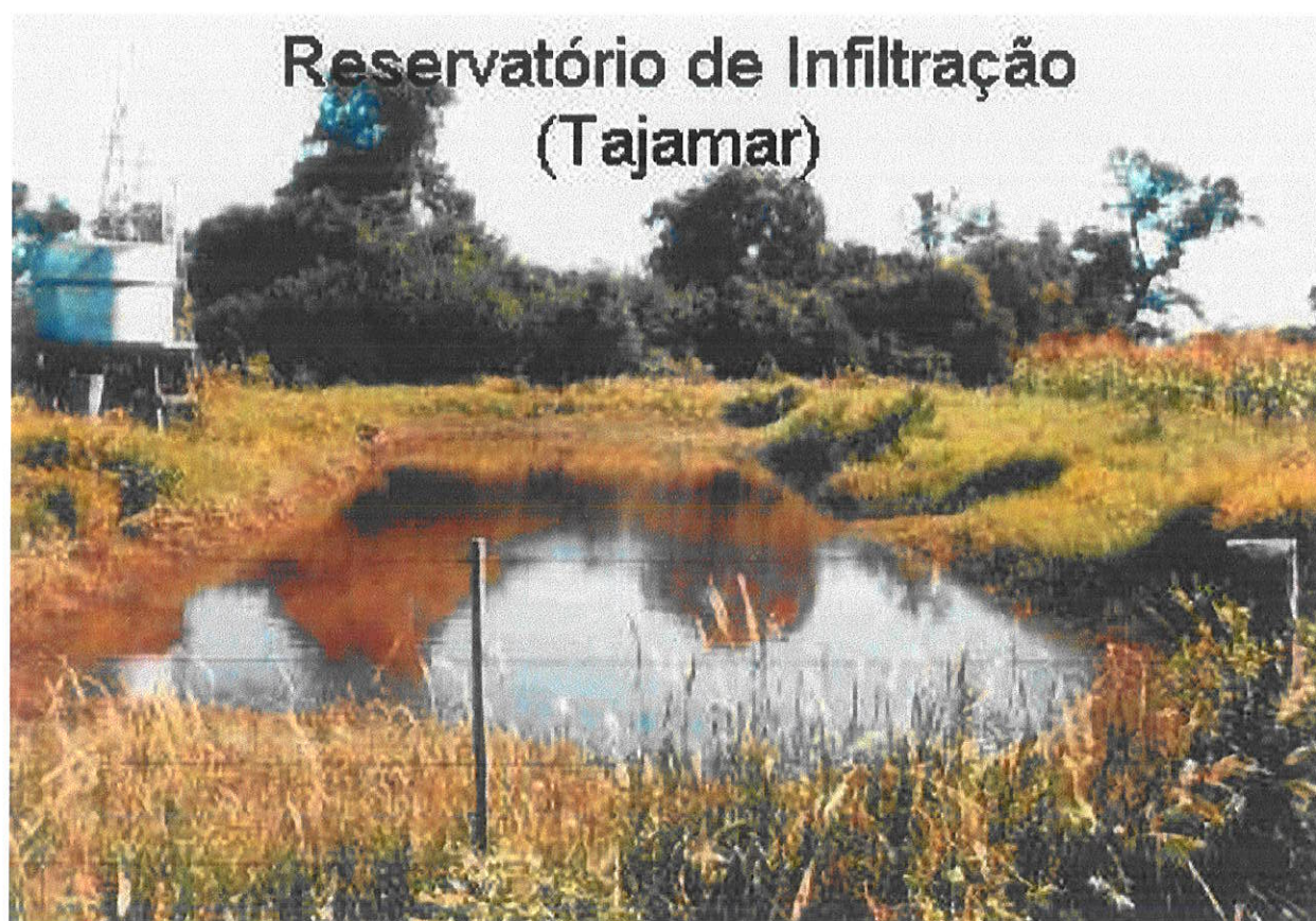
Fig. 8 - Reservatório de Infiltração (tajamar) para recarga artificial do aquífero freático e tamanho pequeno, pode-se observar o poço com o reservatório elevado ao fundo.
