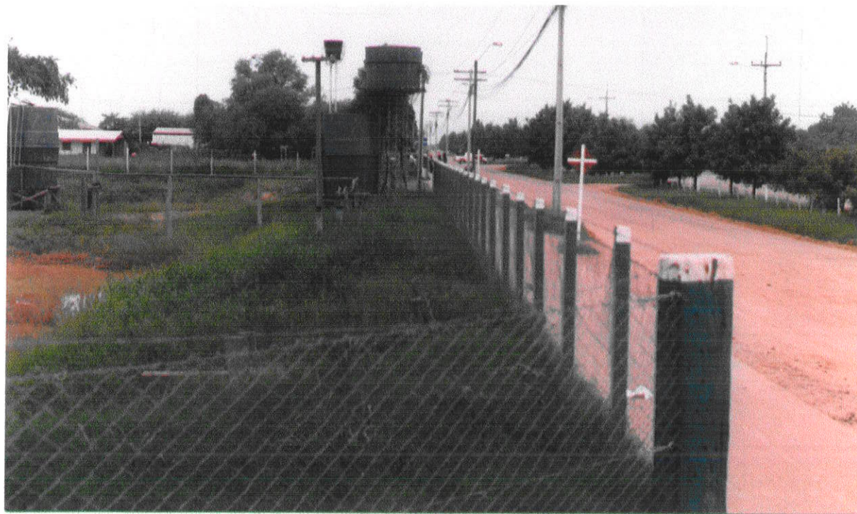
Fig. 18 - A foto mostra como é protegido alguns Reservatórios de Infiltração com alambrados, observando-se também os poços de exploração da água subterrânea.
