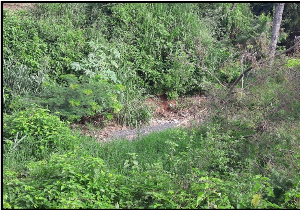
Figura N° 27: Cárcavas producidas por el agua de lluvia con material depositado
