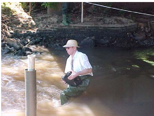
Extracción de piedras del Cauce, se observa también los caños galvanizado y plástico
