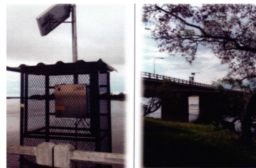
Figura 28: Imágenes de la estación Hidrométrica de Villa Florida
