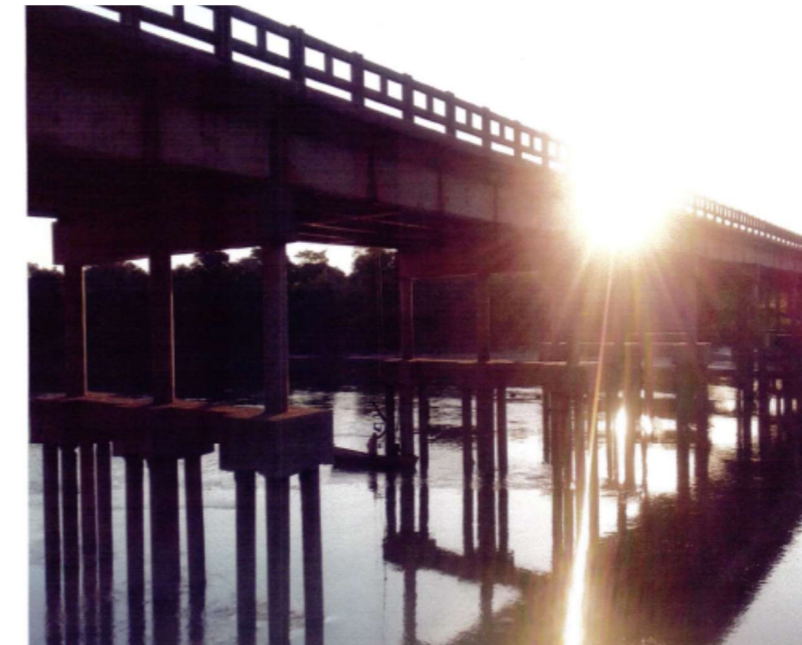
Figura 33: Imágenes de la instalación de la estación Hidrométrica en Iturbe
