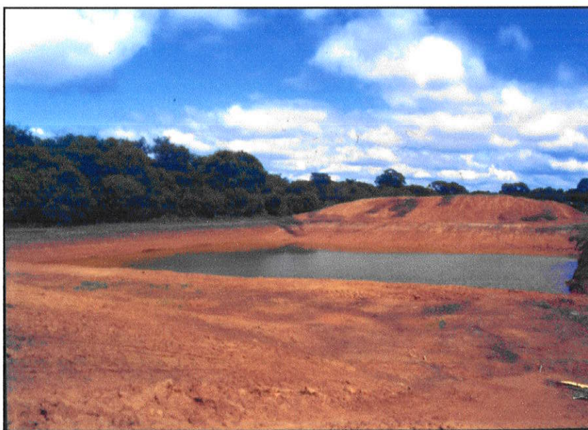
Figura 8.5 Reservatório não permeável (material argiloso/morfologia de monte)
