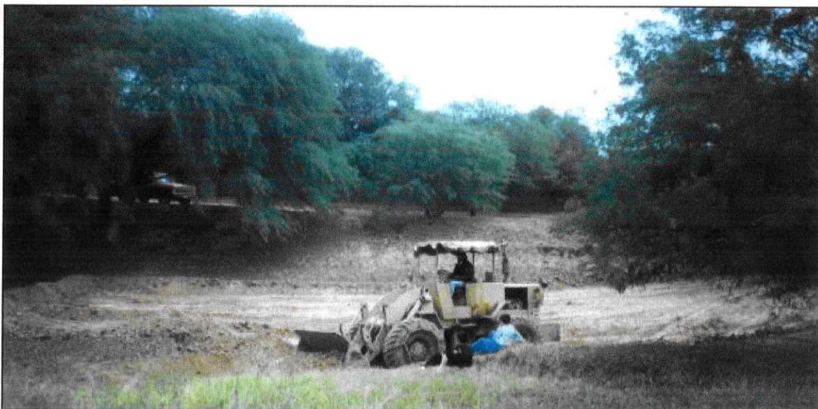
Figura 8.4 Limpeza anual (tempo da seca) da base do reservatório de infiltração (tajamar) para facilitar a infiltração da água de chuva para o aquífero (Reservatório de infiltração Serenidad em Filadelfia).
