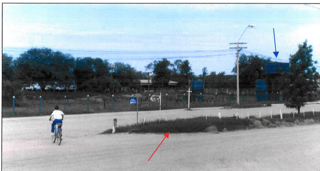
Figura 8.3 A água de escoamento das precipitações chega mediante drenos instalados nas ruas ao reservatório de infiltração – tajamar- (flecha vermelha). A água subterrânea, mediante a extração por poços, é elevada aos tanques para ser comercializada (flecha azul).
