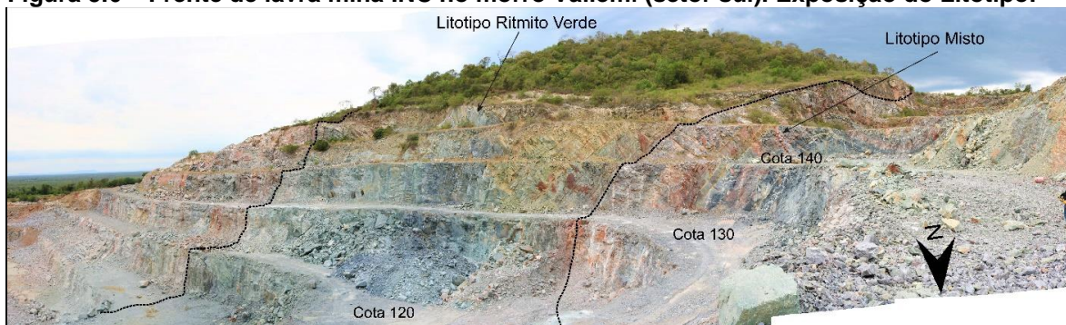
Figura 5.6 – Frente de lavra mina INC no morro Vallemí (setor sul). Exposição do Litotipo.
