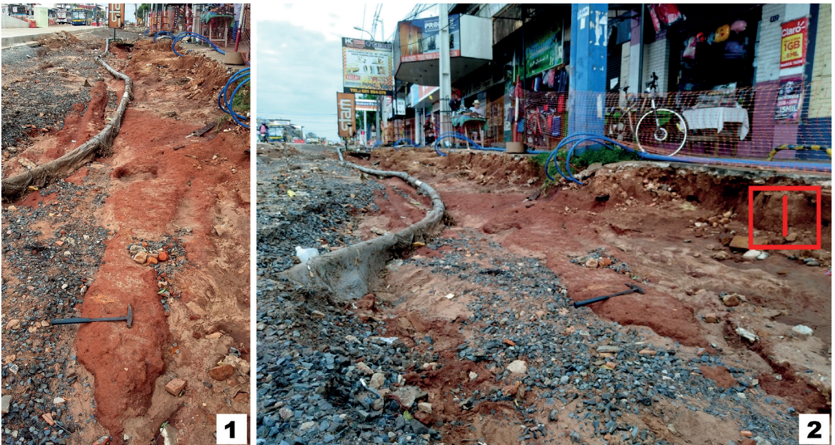
Figura 3. Afloramiento de arenisca Ita Pytã Punta. 1) Disposición de afloramiento de arenisca Ita Pytã Punta. en el entorno de los trabajos del Metrobus en Fernando de la Mora. 2) Suelo rojizo poco desarrollado de cobertura (<40 centímetros).
